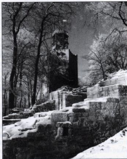
Das Starfoto des Bergfriedes auf der Oberburg (Kernburg) von Sigrid Lux
