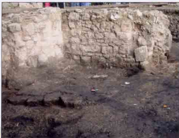
Fußbodenbelag in der nordwestlichen Ecke
